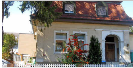
Hier entsteht eine Wohngemeinschaft. Foto: bw
