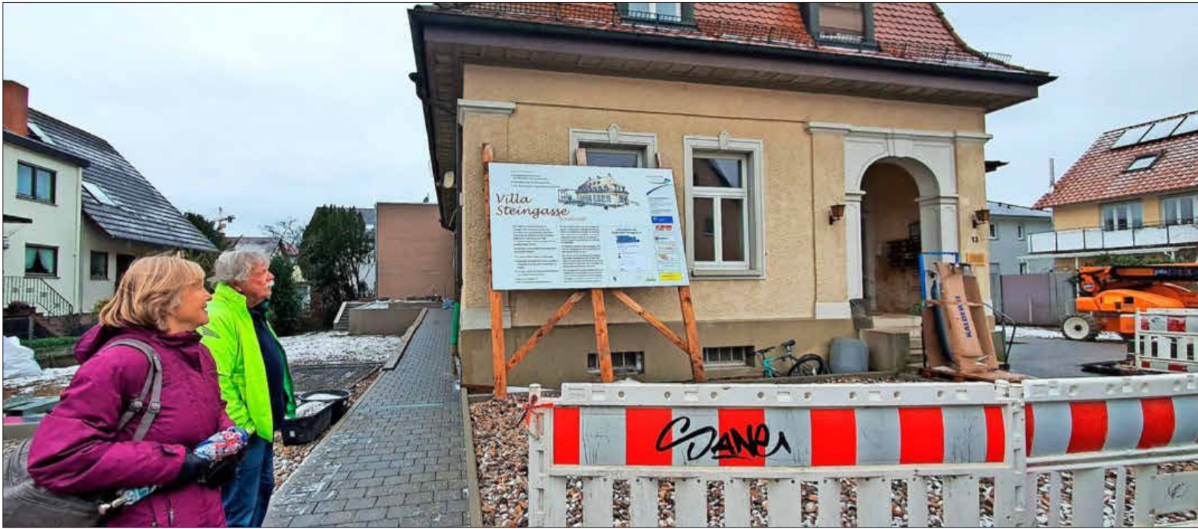
Luise Lutz und Wolfgang Perach vom Bürgerverein Steingasse auf der Baustelle der Villa Steingasse
